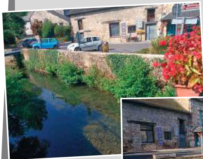
Mur avant travaux
